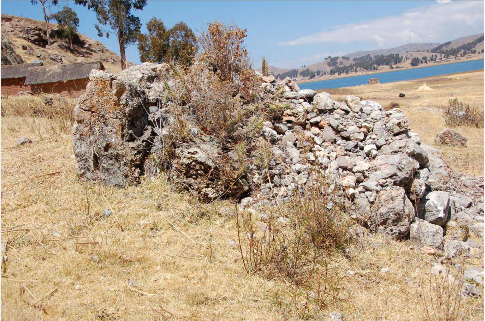
Cimiento de estructura circular. 3.50 x3.50 m y 0.70 m de alto
